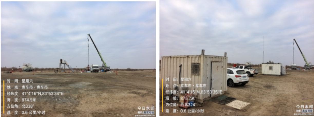
图 3.2-1 井场现状现场照片（正在拆除钻井设备设施）
